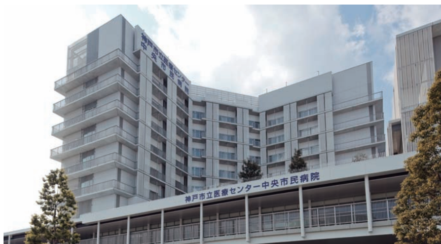
■神戸市立医療センター中央市民病院 ■病床数 700床（一般690床） ■職員数 1571人 ■DPC/PDPS 平成21年4月
